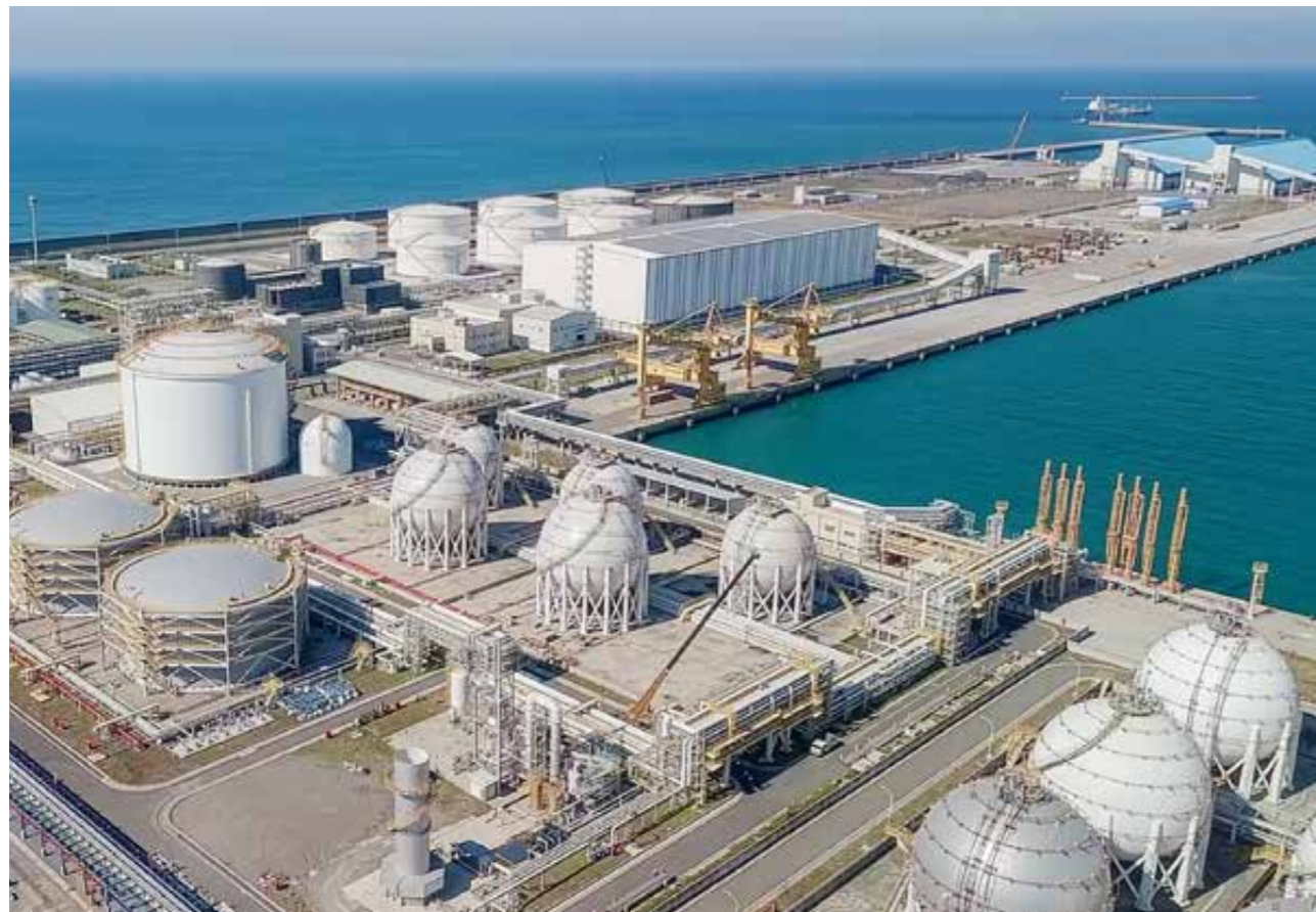
台塑公司洲際儲運中心
