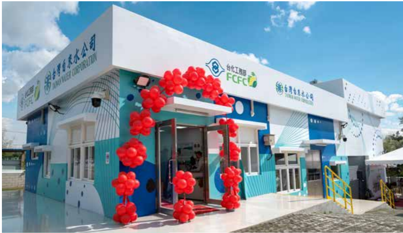
台化沙鹿配水中心小水力發電案場
